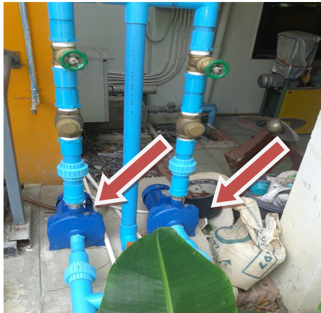
P6 ปุ่มสูบน้ำประปาจ่ายน้ำอาคารมหิดลวิทยานุสรณ์ 1 (ปุ่มอยู่ฝั่งด้านขวาหลังห้องพักเจ้าหน้าที่ฝ่ายวิทยบริการ)
