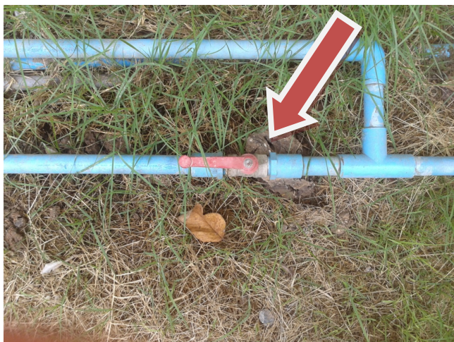
หมายเลข 14 วาล์วควบคุมน้ำประปาเข้าแท็งก์น้ำโรงเพาะชำอยู่ด้านข้างอาคารศรีระวิทยา
